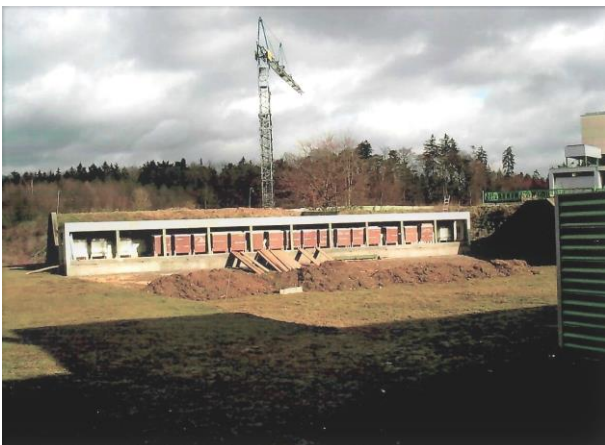
Sanierung des 50m-Standes im Frühling 2004.
